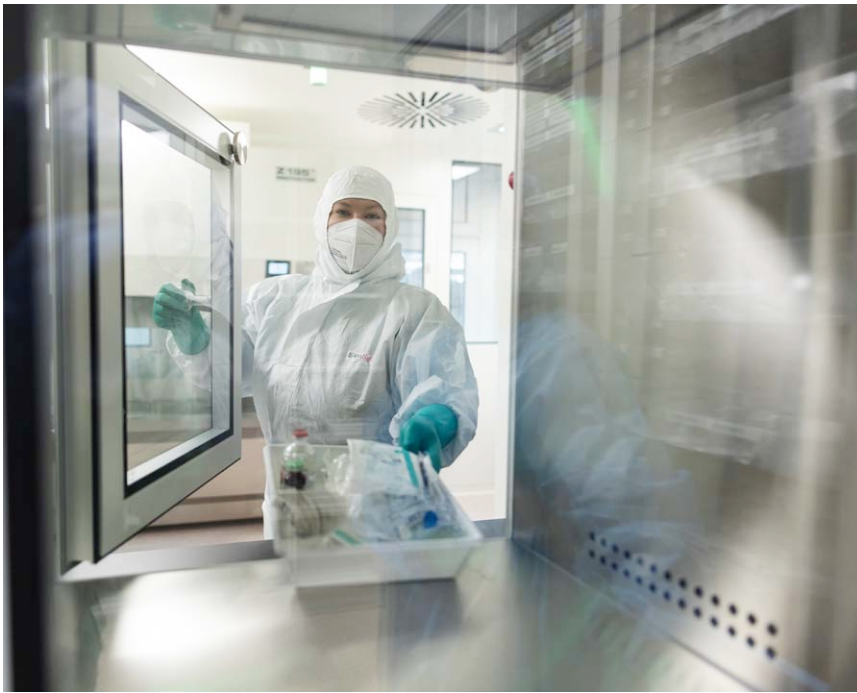
Die fertigen Zubereitungen an Zytostatika gelangen auch wieder durch Schleusen aus den Reinnräumen hinaus. Die PTA, die sich in Reinraum C befindet, übergibt hier die Infusionsbeutel mit den Medikamenten über die Materialschleuse an die Apothekerin, die eine letzte Sichtkontrolle vornimmt. Bild: Augusta Kliniken Bochum
