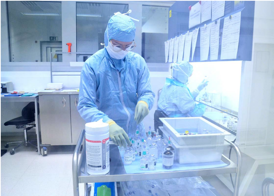
In diesem Reinraum (Klasse B) befindet sich eine Werkbank, deren Innenraum Reinraumklasse A entspricht. Hier werden die Arzneimittelzubereitungen vorbereitet. Bild: CAT Clean Air Technology
